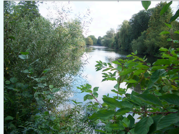
Auch der dritte Stauteich muss dringend entschlammt werden.
