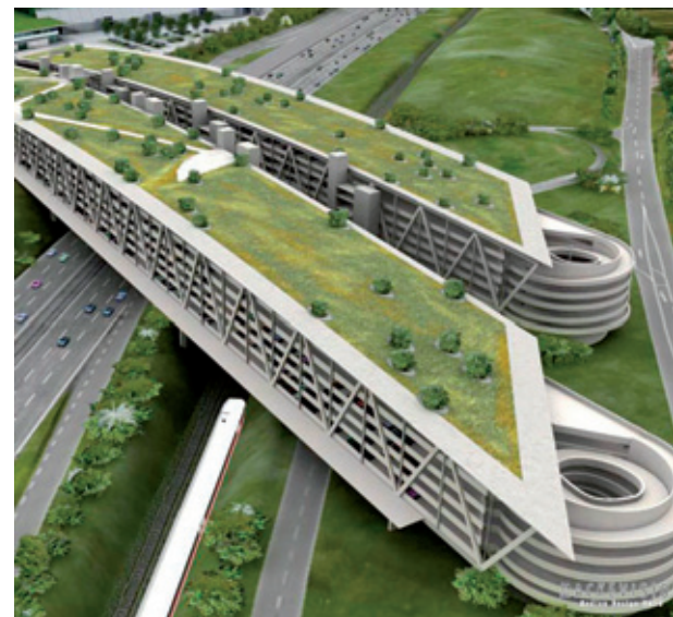
Die Überbauung der Parkhäuser ist statisch kein großes Problem. Ein Beispiel ist die Überbauung der Autobahn der Messe Stuttgart, wo Spannweiten von ca. 100 Metern bewältigt werden. Billiger als ein Neubau auf der grünen Wiese ist das nicht, aber dafür kann man alle vorhandene Infrastruktur (v. a. Stadtbahn) abrechnen.
